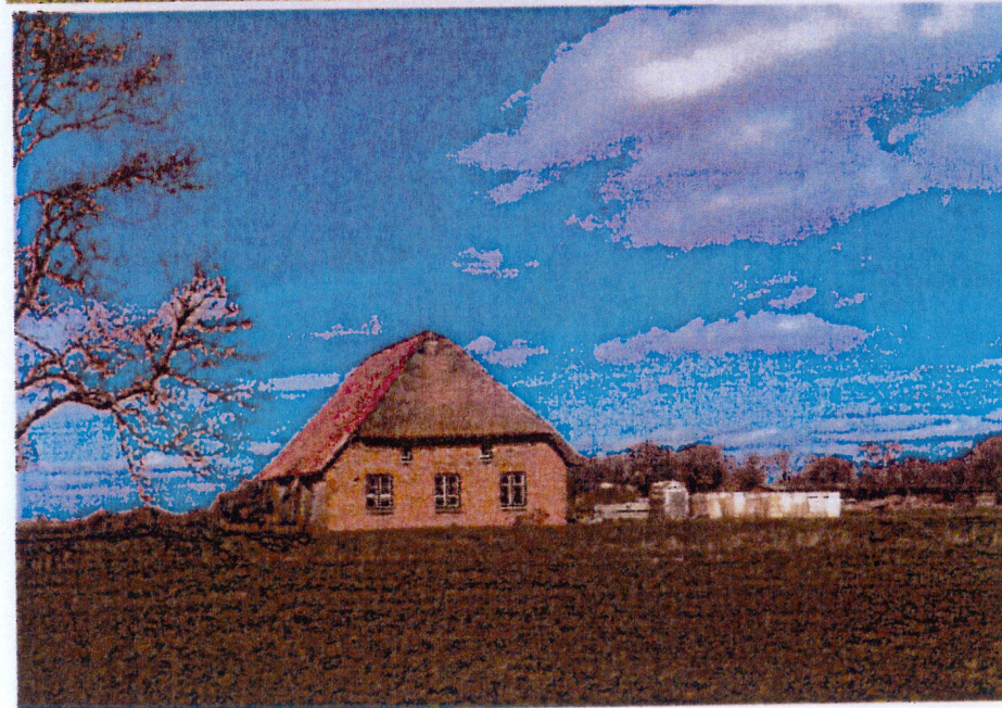
Ehemaliges Wohnhaus der Ziegler im heutigen Zustand. Sichtbar ist ein Teil der Restmauer des Anbaus.
