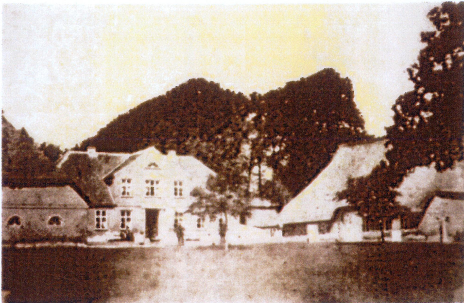
Großwarft Drandersumkoog, Staatshof, Foto 1867, Quelle: Archiv Kombüttler Dörpsgeschichte (KDG) e.V.
